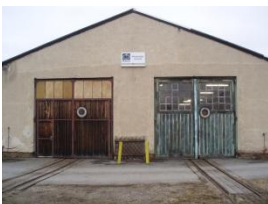
© NÖ Landesrechnungshof vormaliges Werkstättengebäude der Waldviertelbahn auf dem ÖBB-Gelände
