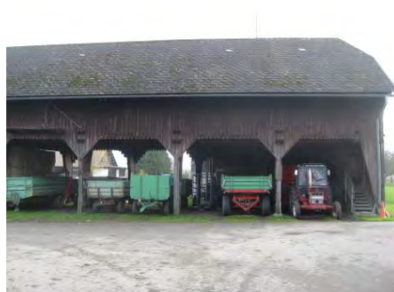
Maschinenhalle in Edelhof
