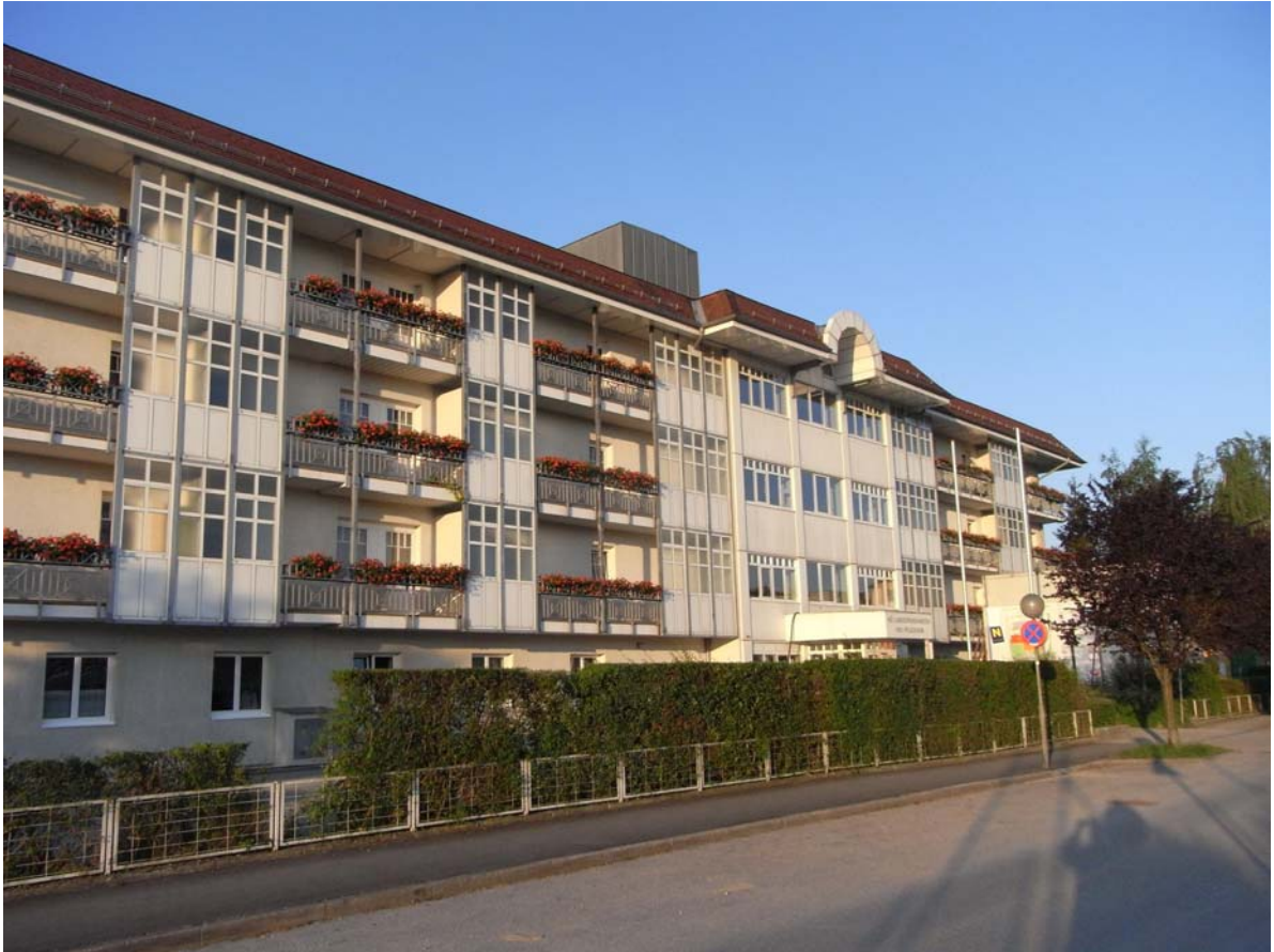
Ansicht Nordtrakt des Heims; Quelle: Heimleitung
